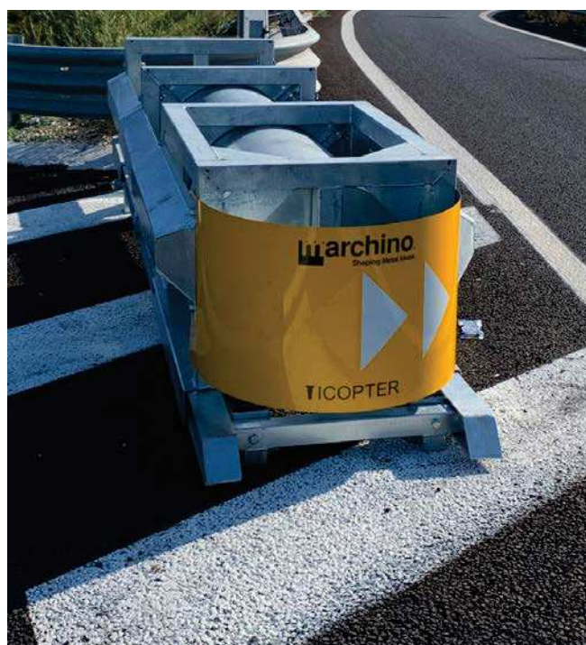
Figura 22: Esempio di installazione ZMP50
