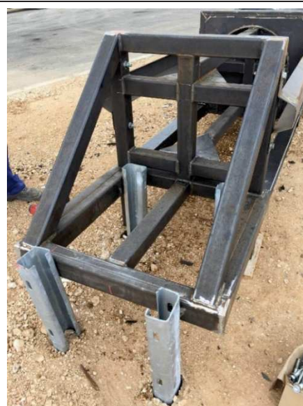
Figura 9: Collegamento posteriore pali 120x80mm
