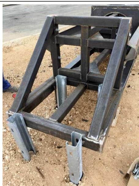
Figura 9: Collegamento posteriore pali 120x80mm
