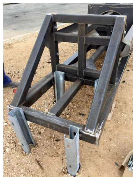
Figura 9: Collegamento posteriore pali 120x80mm
