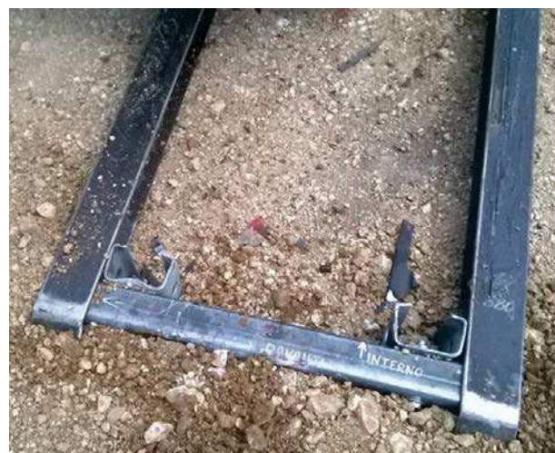
Figura 7: Collegamento anteriore pali 120x80mm
