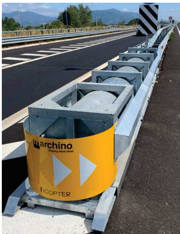
Figura 21: Esempio 1 di installazione ZMP80
